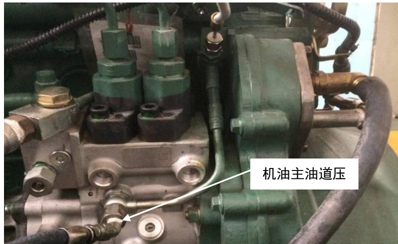
图B.13 机油主油道压力测量位置
